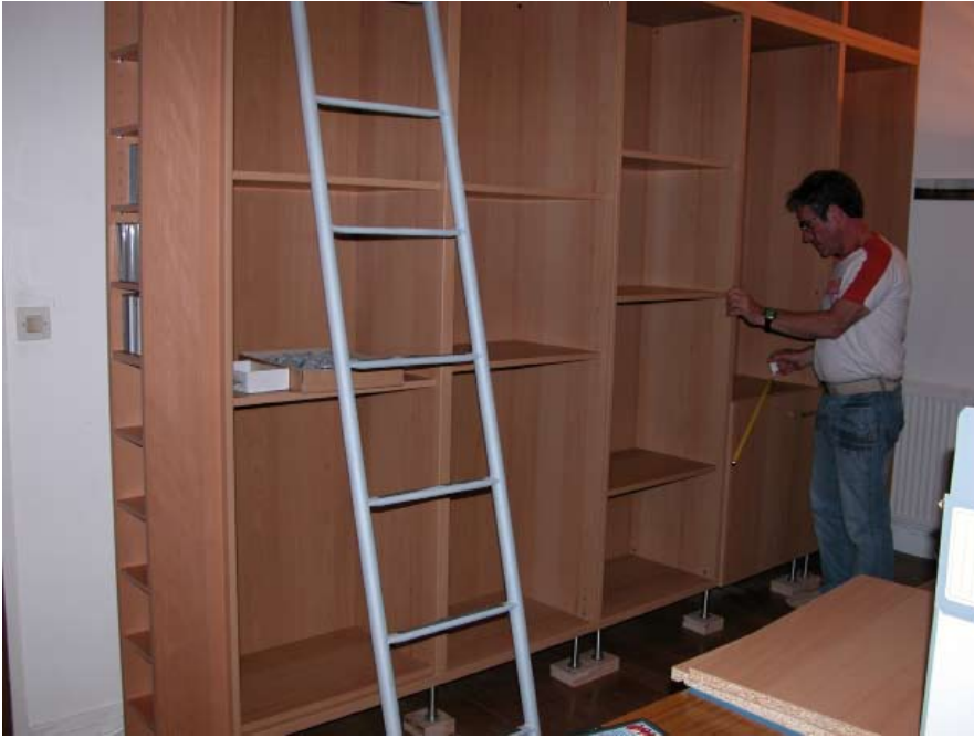
Montage et mise en place de la bibliothèque au local.
