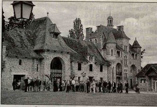
Cour intérieure du château des Dames
